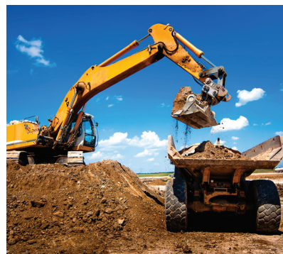
图 2: 即使在正常环境条件下, 非路面设备也会很快发生腐蚀
